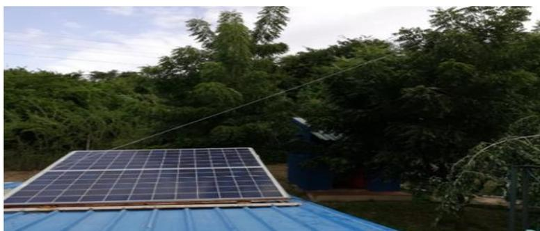
**Figura 7 Sombreamento dos Painéis Solares**
