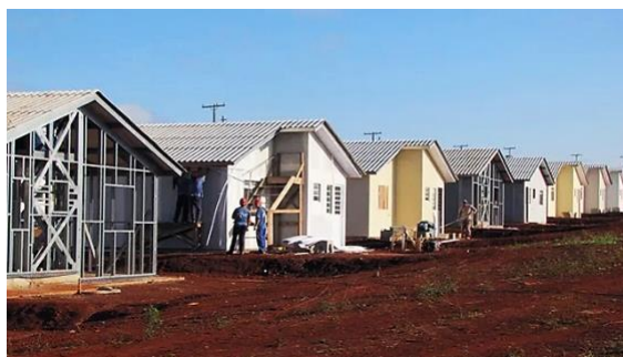
Figura 02 – Residências Padrão Minha Casa Minha Vida Utilizando Steel Frame e Drywall
