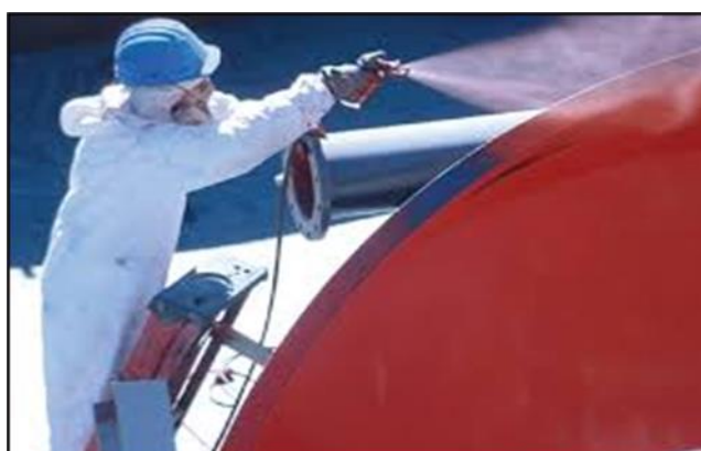
Figura 4: Aplicação de revestimento
