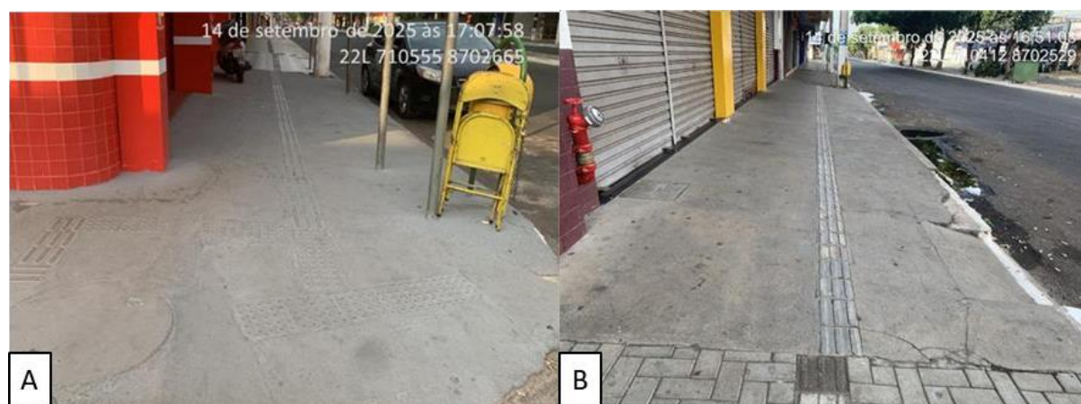
Figura 9. Ausência de pintura no piso tátil com o piso adjacente em diversos trechos da via.
