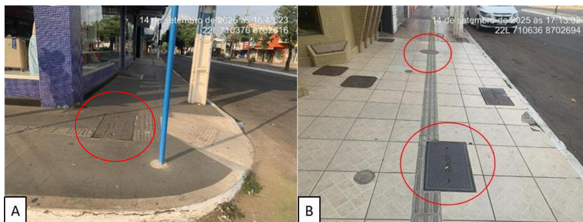
Figura 7. Pisos táteis com a presença de obstáculos, Caixa de Terminação e hidrante de recalque.
