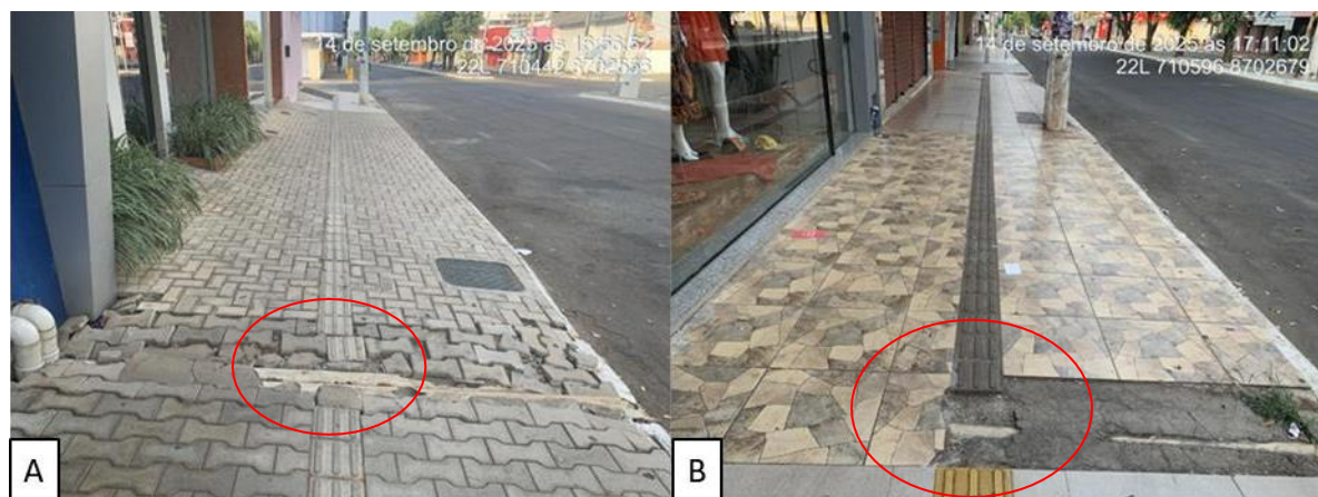
Figura 8. Pisos táteis danificados pela interferência de canos.
