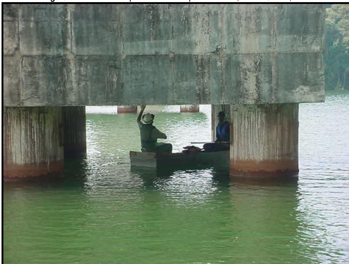
Figura 17 - Tubulão de ponte sobre a represa do Peti, Minas Gerais, Brasil.
