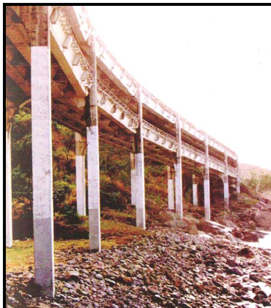
Figura 4 - Elevado do Joá exposto à atmosfera marinha, agressiva.
