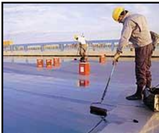
Figura 9 - Tabuleiro de ponte na aplicação de imprimação da impermeabilização
