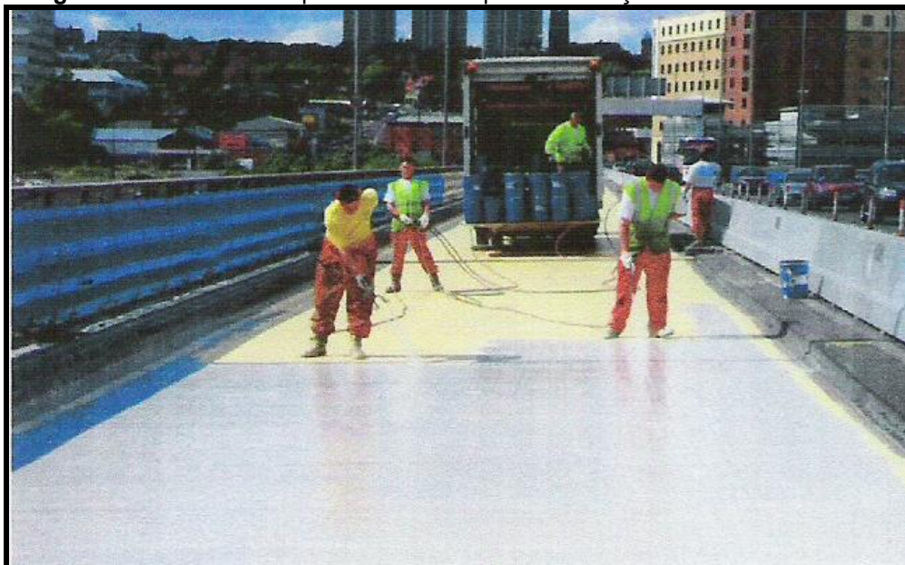
Figura 15 - Tabuleiro de ponte durante impermeabilização com sistema airless.
